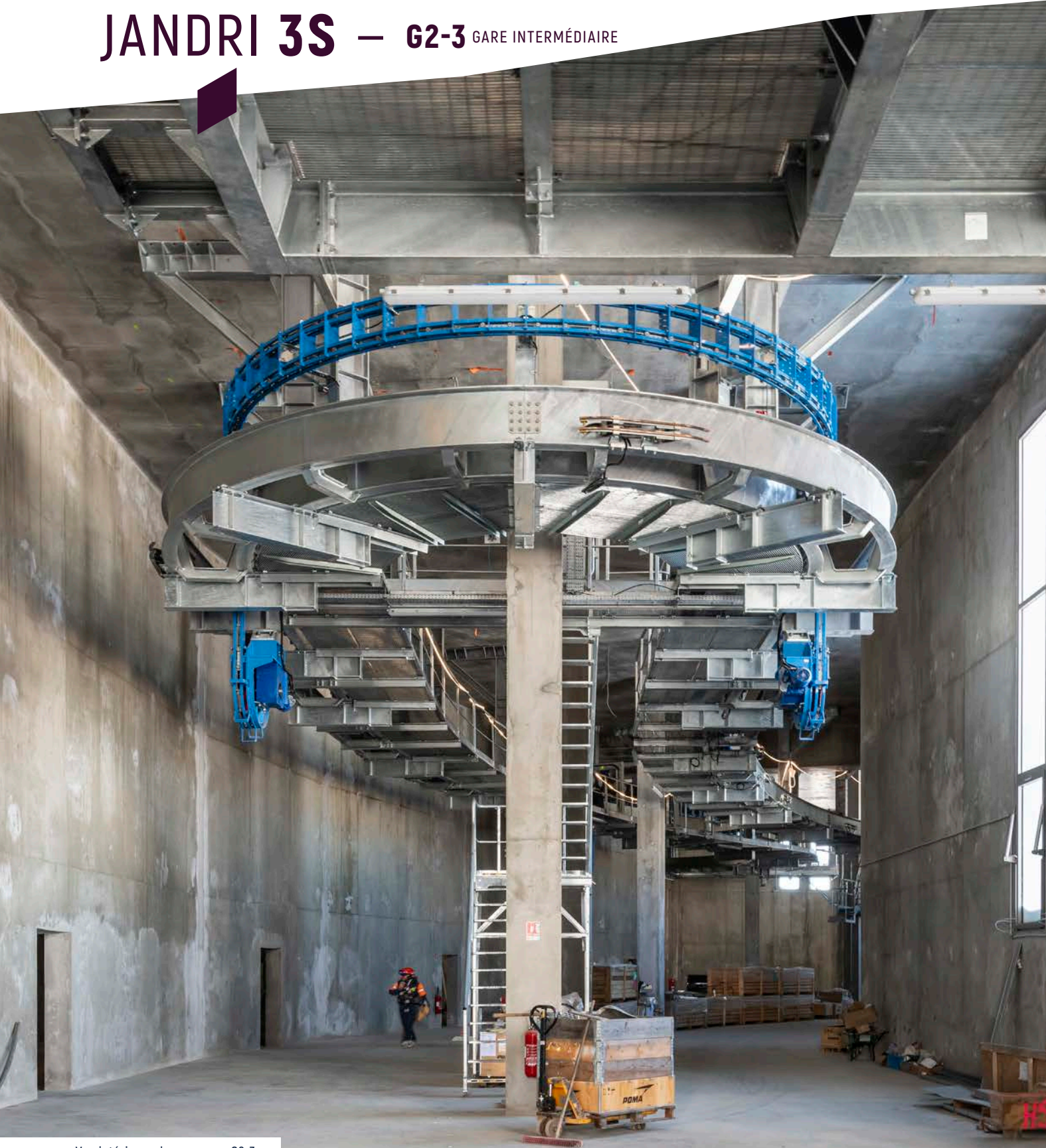
Vue intérieure du garage en G2-3
